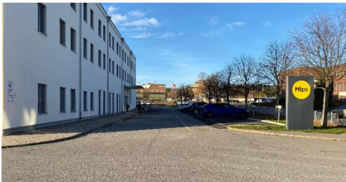
Figur 2-3. Bild från platsbesök längs fastighetens östra sida. Foto: Structor Mark Uppsala AB 2020.
