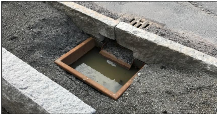
Figur 5-4. Anläggning av inloppsbrunn till planteringsyta med gallerbetäckning och spridningskär! Foto: A. Thorsell Structor Mark Uppsala AB (2019).
